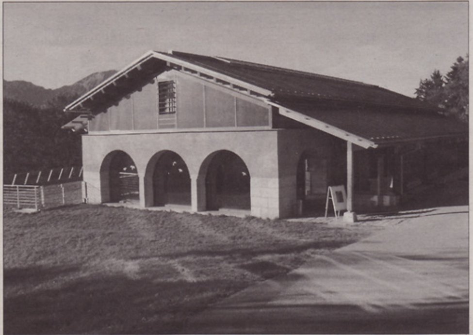
Ansicht des Dokumentationszentrums Obersalzberg von Süden (Institut für Zeitgeschichte München-Berlin / Foto: Max Köstler, Berchtesgaden).
